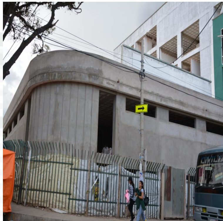
PROYECTO: AMPL. REFACC. TERAPIA INTENSIVA Y FARMACIA H. JAIME MENDOZA SUCRE MONTO DEL CONTRATO: Bs. 3,745,983,54
